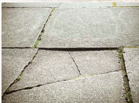
陥没したコンクリートの補修
