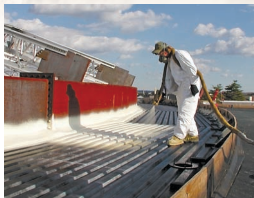
屋上断熱・防水
