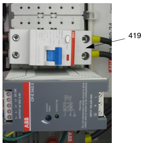
FIG. 32: Aardlekschakelaar
