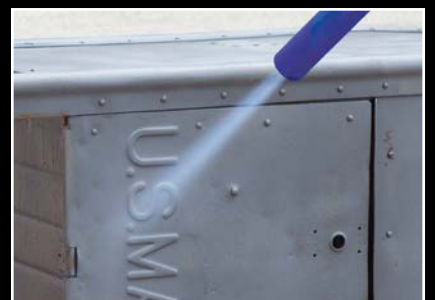
Preparazione di superfici in acciaio
