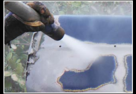
Rimozione del rivestimento
