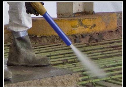
Restauración y reparación de hormigón
