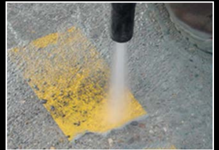
Preparación de superficies de hormigón
