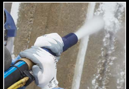
Limpieza de hormigón
