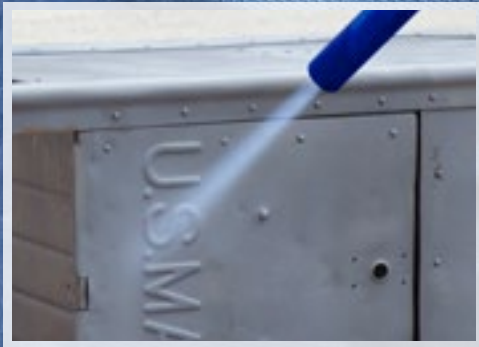
钢结构表面处理
