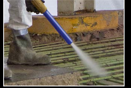
Beton Onarımı ve Yenilemesi
