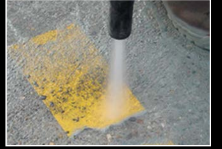
Beton Yüzey Hazırlığı
