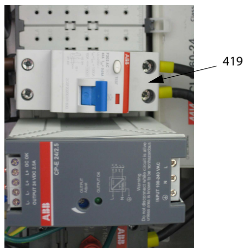
Рис. 32. Выключатель короткого замыкания на землю
