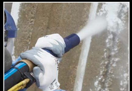
Reiniging van beton
