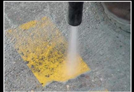
Voorbereiding van betonnen oppervlakken
