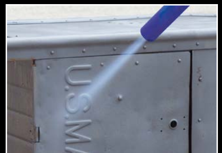
Förbehandling av stålytor
