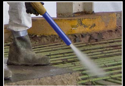
Reparation och restaurering av betong
