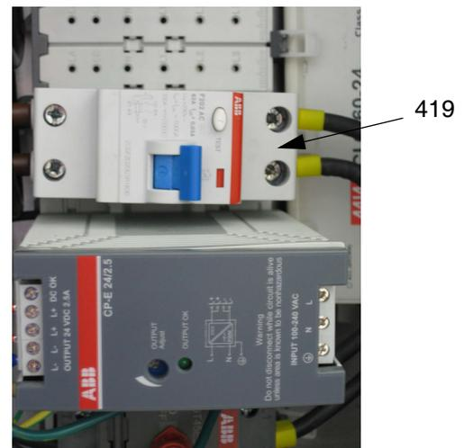
FIG. 32 : Disjoncteur de mise à la terre en cas de défaillance du circuit
