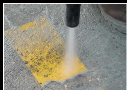
Przygotowanie betonowej powierzchni
