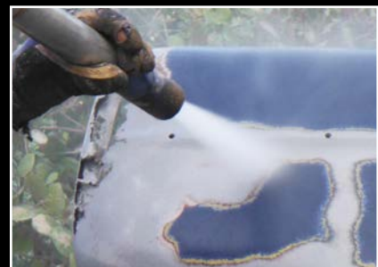
Usuwanie powłok
