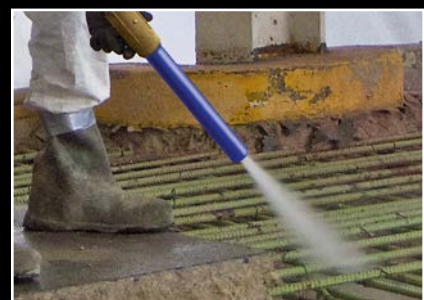
Naprawa i odnawianie betonu
